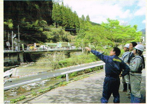
4月17日 熊本地震による矢部村の国道442号通行止 箇所災害現場視察 (大家敏志参議院議員に説明)
