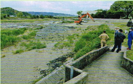
2021年4月23日 矢部川右岸災害復旧(津江)
