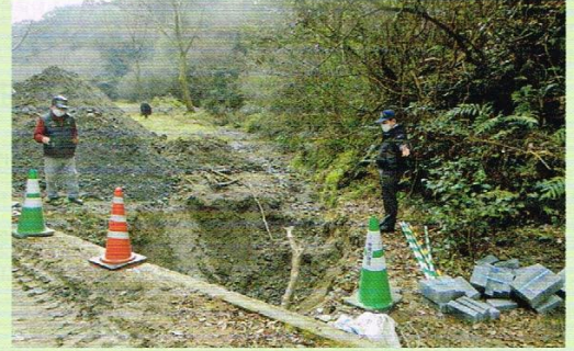
2021年2月11日 広川ダム周辺水路改修(広川町)
