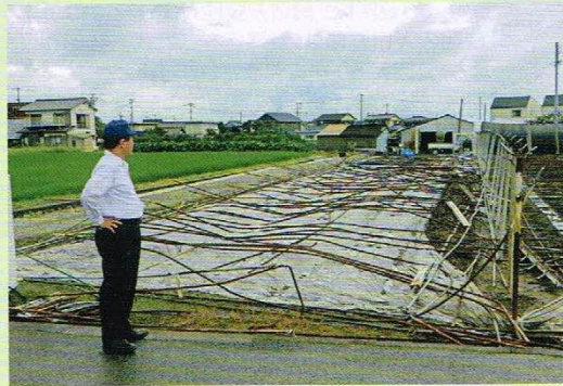
2020年7月25日 忠見突風によるハウス倒壊
